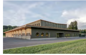
KNIE Ersatzneubau Winterquartier Wagnerfeld, Rapperswil-Jona // Direktauftrag // Fertigstellung 2025 // CHF 11 Mio.
