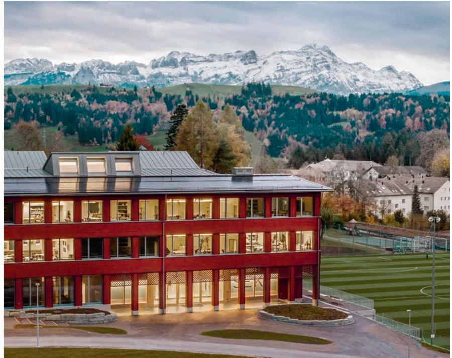
*Die Holzfassade in roter Farbe ist in Appenzell seit jeher ein bewährtes Element, die Dachlandschaft mit sechs Lukarnen und integrierten Photovoltaikpaneelen jedoch von neuester Technik. Sie ist mit Zinkblech eingekleidet.*
