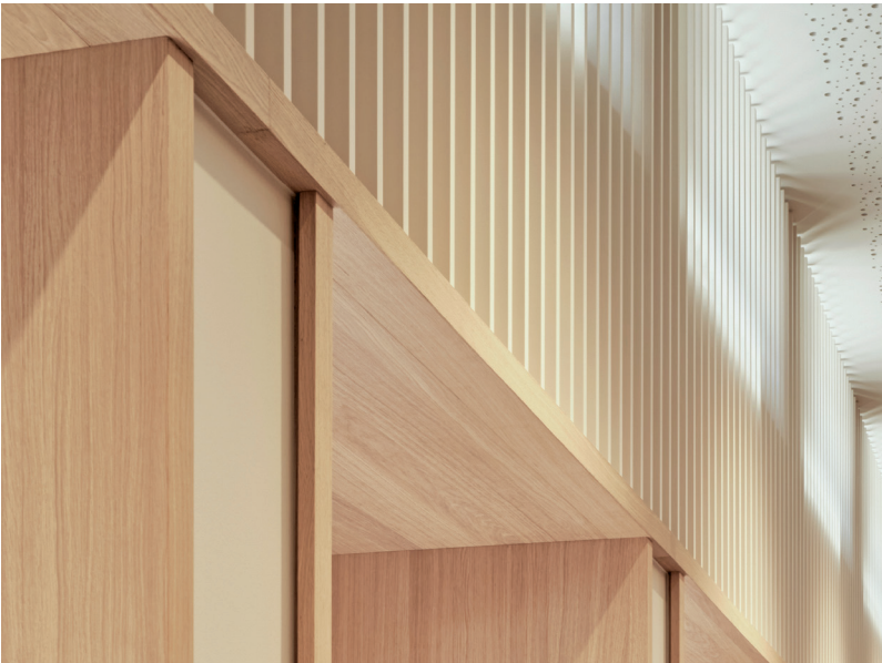
Die spezielle Lamellenstruktur – bestehend aus sogenannten Schröder-Diffusoren – an den Innenwänden des Löwensaals lässt die Raumakustik zum besonderen Hörerlebnis werden.
