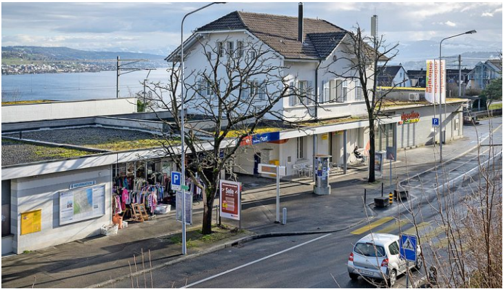
Die SBB möchten das ehemalige Postgebäude (links im Bild) des Bahnhofs Oberrieden Dorf umbauen. Foto: Michael Trost
