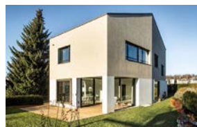
Einfamilienhaus Rütiwiesstrasse, Jona // Fertigstellung 2015
