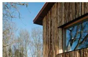
Holzhaus am Waldrand, Wolfhausen // 1. Rang, Kat. Neubau, Werkschau SIB 2007 // Prix Lignum, Holzpreis Schweiz 2009 // Fertigstellung 2007
