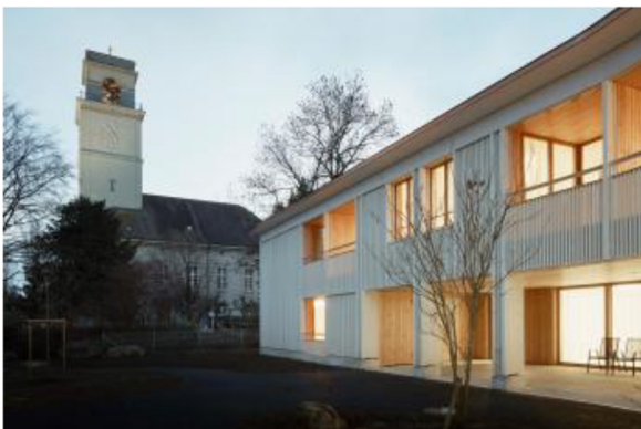
Gemeinschaftsräume und gedeckter Aussenraum
