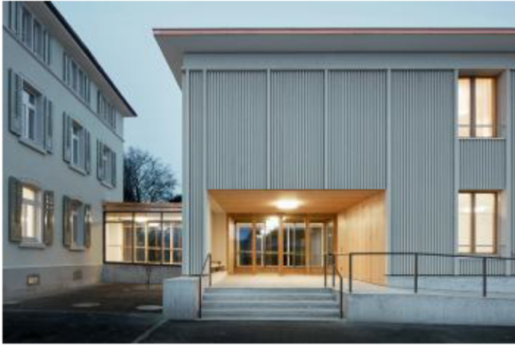
Haupteingang Neubau mit Anbindung Villa
