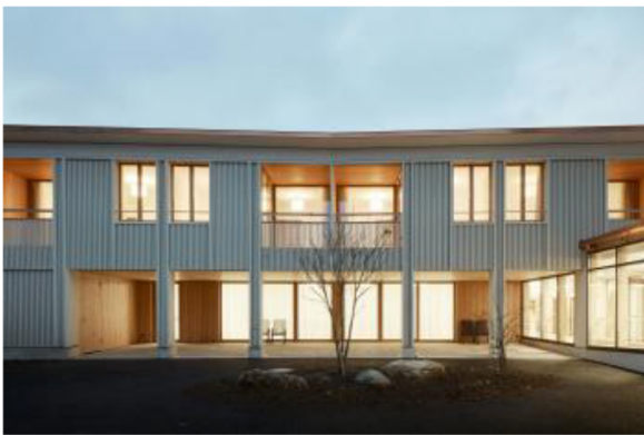
Holzfassade behandelt mit Roggenmehl
