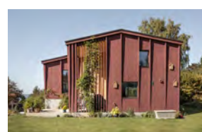
Einfamilienhaus Chapfstrasse, Zumikon // Fertigstellung 2021 // CHF 1.3 Mio.
