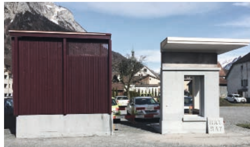
Bemusterung der Fassade mit Sichtbetonsockel und Holzfassade.
